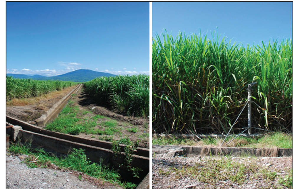
Figura 6 Sistemas de riego rodado y por aspersión en la zona cañera de Tamazula
