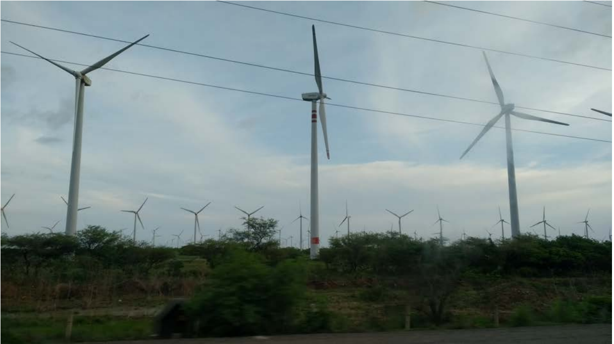
Parque eólico La Venta, Oaxaca
