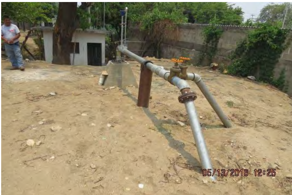
Perforación de pozos profundos para atender la emergencia de sequía
