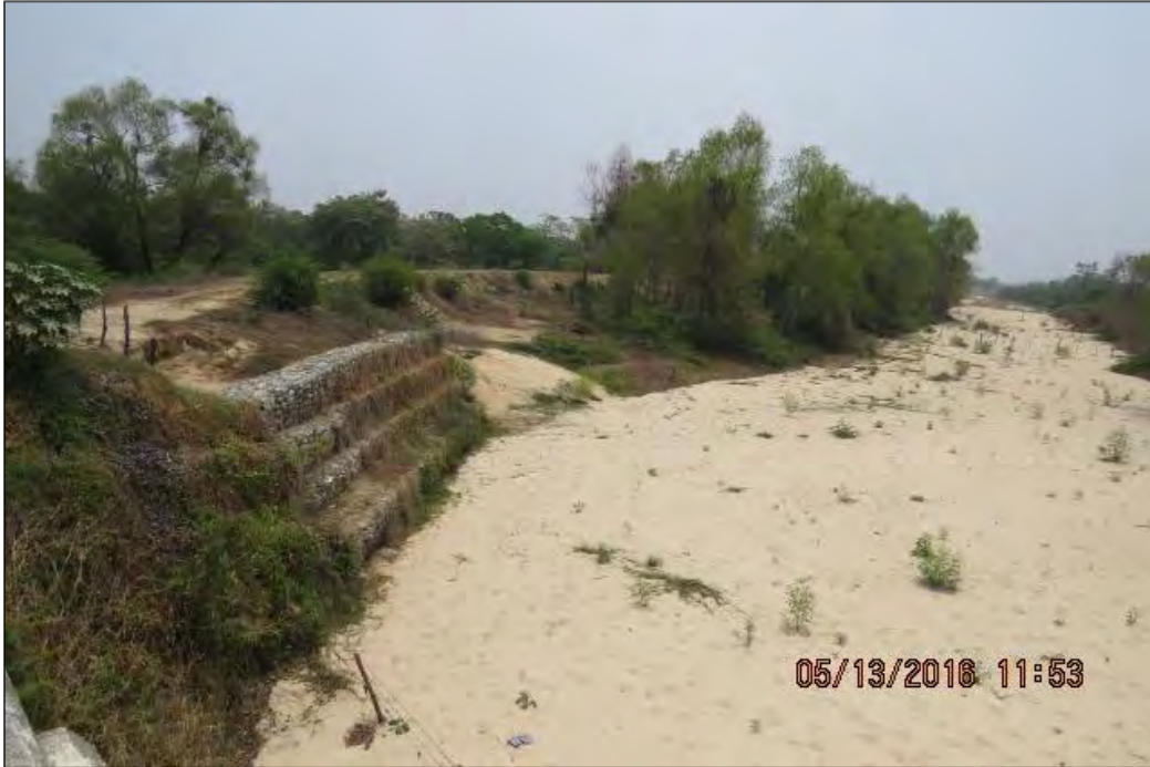
Obra de restitución de bordo en el cauce del río Zanatenco
