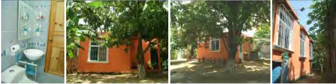
Figuras 9: Procedimiento Constructivo de la Vivienda.
