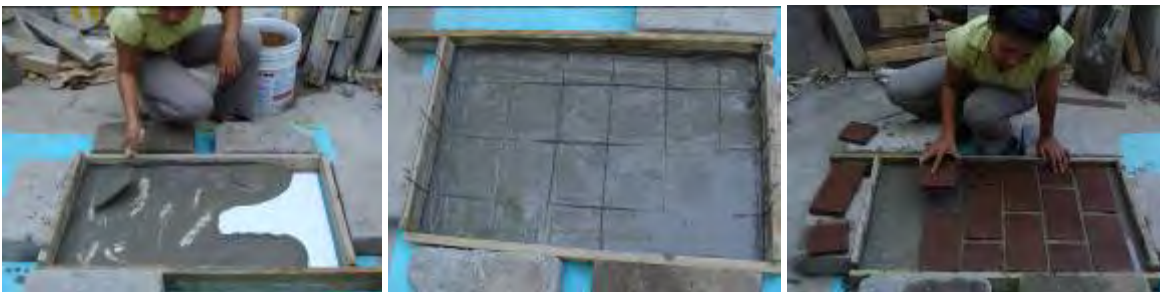
Figura 8: Procedimiento Constructivo de Termolosa.
