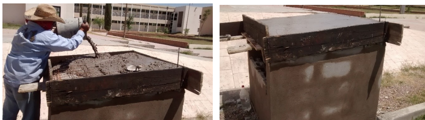
Figura 7. Colado de los de concreto de 10 cm
