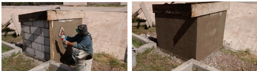
Figura 6. Proceso de repello de los muros
