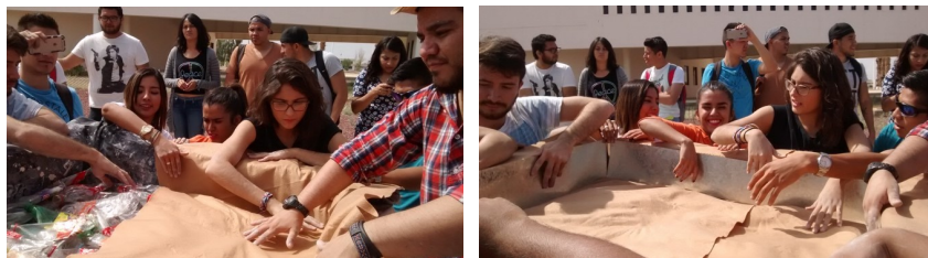
Figura_14.-Colocación del fieltro encima de las dos capas de pet, además de la colocación de las láminas de zinc en el contorno interno de el pretil.
