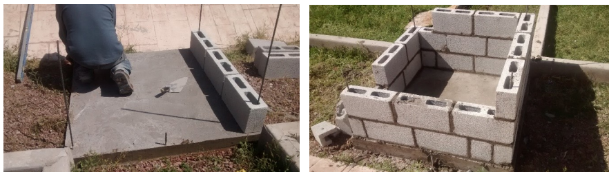
Figura 5.-Proceso de edificación de los muros de los módulos experimentales
