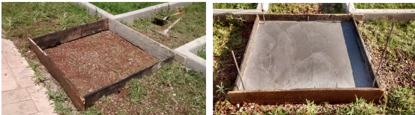
Figura 4. Llosa de cimentación de los módulos experimentales
