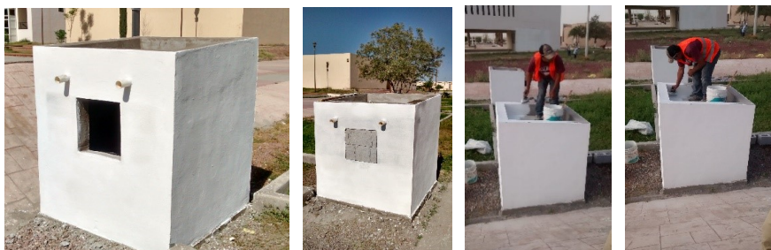
Figura 8. Pintura e impermeabilización
