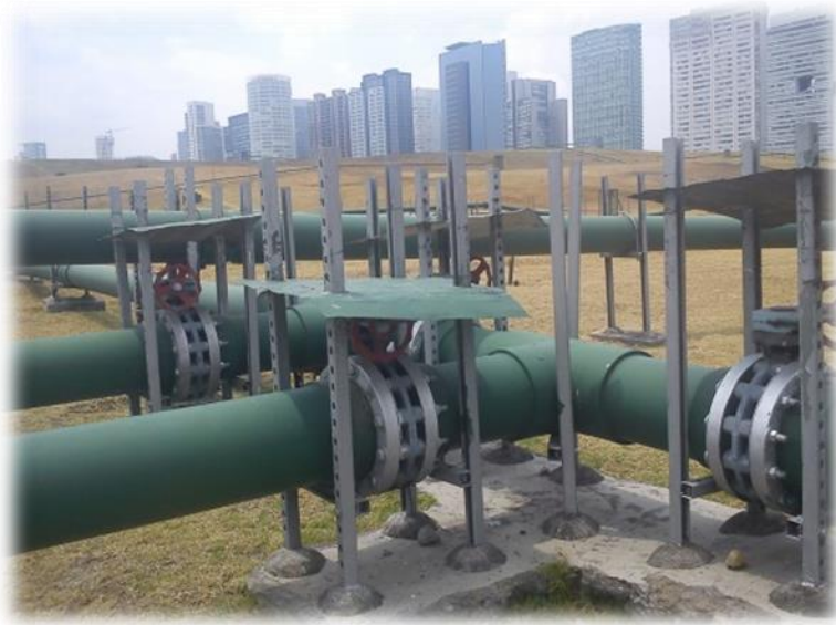
Figura9. Muestra la composición de la red de extracción de Biogás y la vista del SDF-Prados de la Montaña
