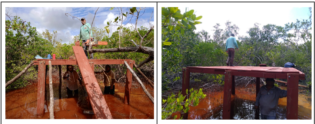
Figura 5: instalación de plataforma donde se instalará la torre (2 tramos de 3m tipo Z45 o Z30) instrumentada con el sistema de Covarianza de Vórtices.
